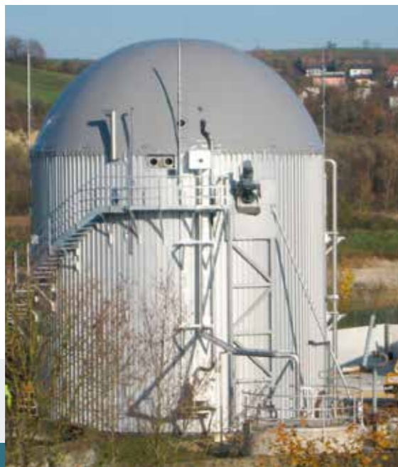
Nachrüstung eines Faulbehälters mit integriertem Gasspeicher für 16 000 Einwohnerwerte auf der Kläranlage der Marktgemeinde Bad Abbach und Umstellung auf anaerobe Schlammstabilisierung
